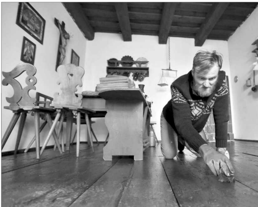
Zámecká kovárna v Holešově na Kroměřížsku se připravuje na novou turistickou sezonu. Na snímku restaurátor Edmond Chlud pracuje na obnově podlahy. FOTO – ČTK/Dalibor GLUČEK
